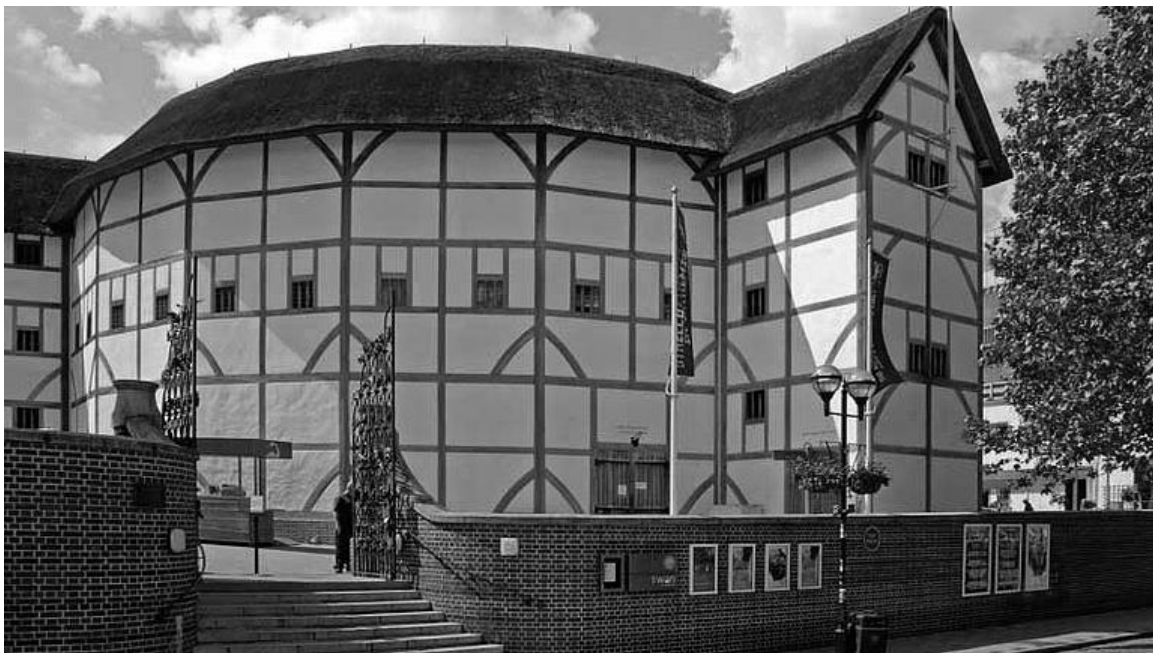
A felújított Globe színház
